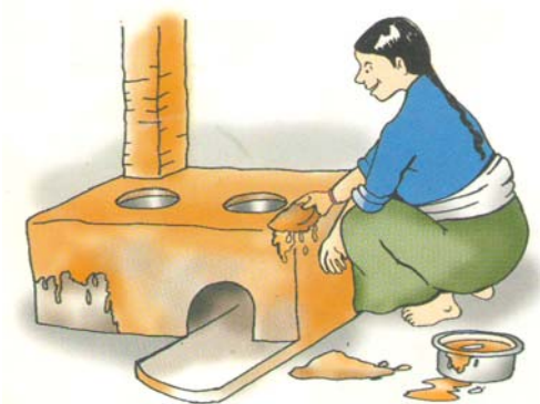
Стяжка поверхности стен печи
