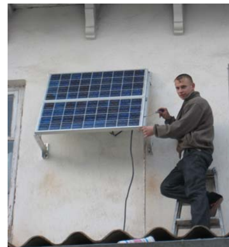
на фото: установка солнечных фотопанелей в офисе организации
