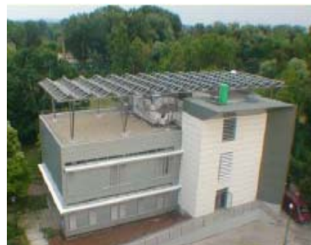
на фото: общий вид здания конференц-центра РЭЦ ЦВЕ
